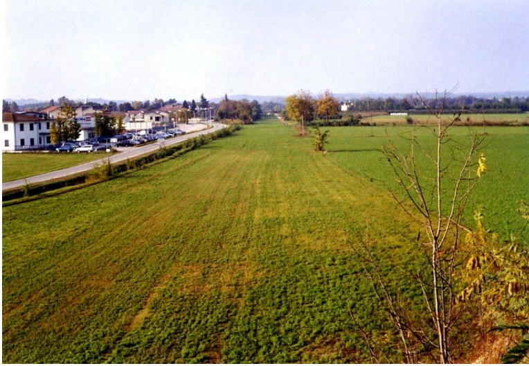
Distruzione del rilevato di Pozzolo di 1 km con altezza di mt 5!
